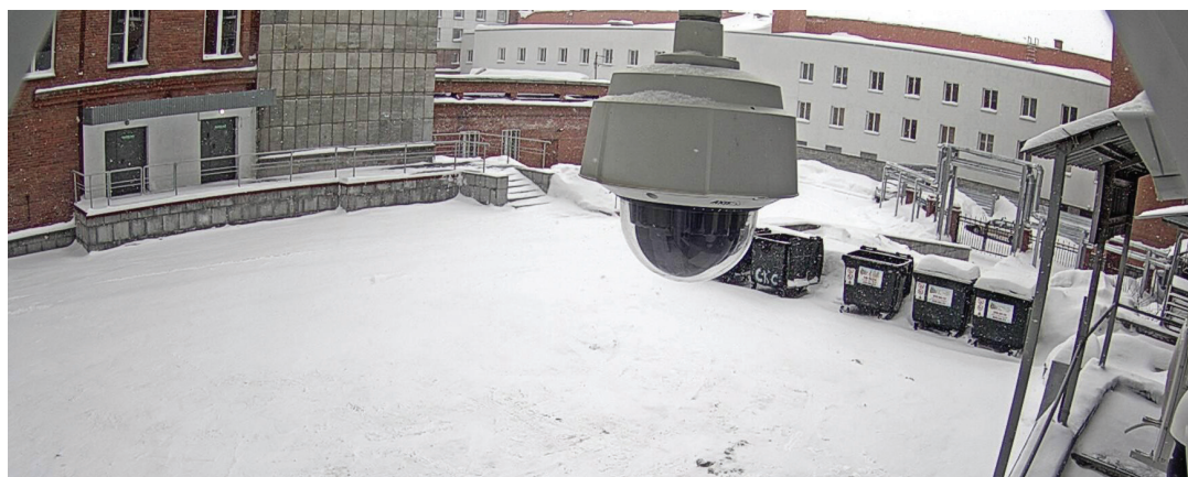
Рис. 6. Камера Axis на площадке в Новосибирске.
