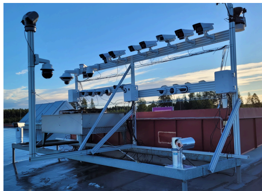
Figure 8. Telecamere di prova Axis installate in loco a Skellefteå.
