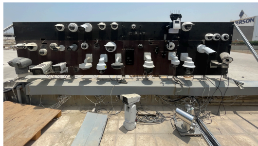
Figure 9. Telecamere di prova Axis installate in loco a Dubai.
