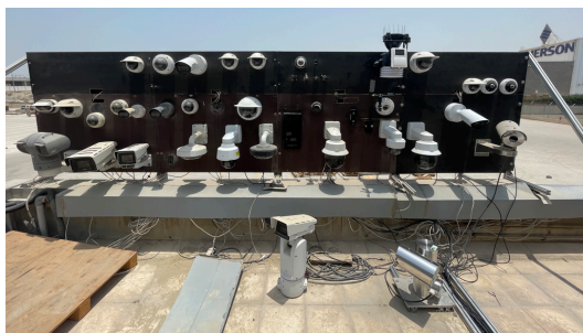
Figure 9. Kamery testowe Axis zainstalowane w lokalizacji w Dubaju.
