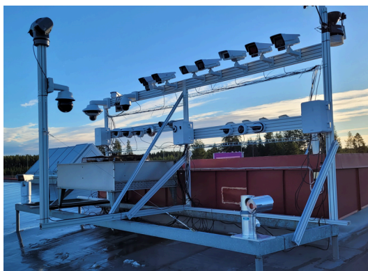
Figure 8. Kamery testowe Axis zainstalowane w lokalizacji w Skellefteå.
