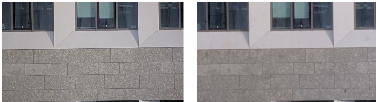
Eine Blende mit zu geringer Öffnung führt zu Beugungseffekten, wie auf dem Bild rechts zu sehen.
