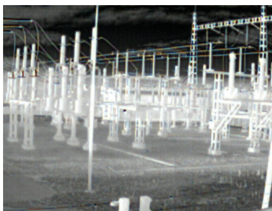
Figure 4. Тот же объект в объективе тепловизионной камеры Axis.
