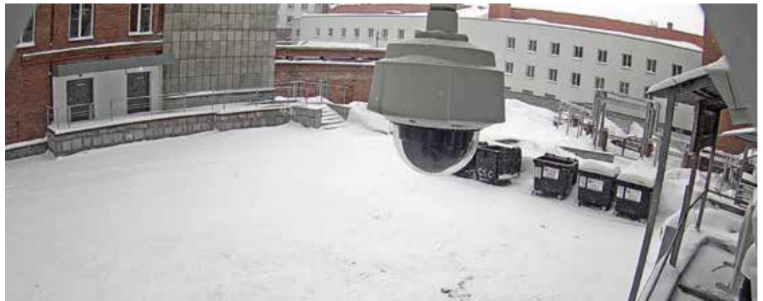
Figure 6 : Caméra de test Axis installée sur le site de Novossibirsk.
