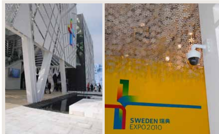
Axis nätverkskameror var installerade i den svenska paviljongen, både av säkerhetsskäl och som service för de anställda, vid världsutställningen Expo 2010 i Shanghai, Kina.
